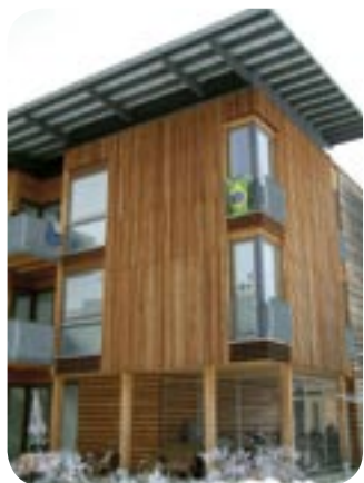
Abbildung 23–25: Wohnanlage Harbach, Siegerprojekt Holzbaupreis Kärnten 2003, Planung: Architektengemeinschaft E. Roth und R. Wetschko, Tragwerksplanung: K. Pock, Durchführung: Holzbau Themessl GesmbH (Bildquelle: Fritz Klaura)
