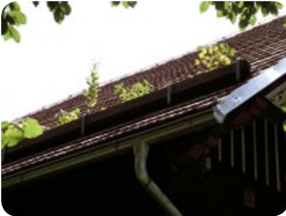
Abbildung 19: Laub im Bereich von Schneefängern und Dachrinnen kann zu Wasser- und Eisrückstau führen (Bilquelle: Fritz Klaura)
