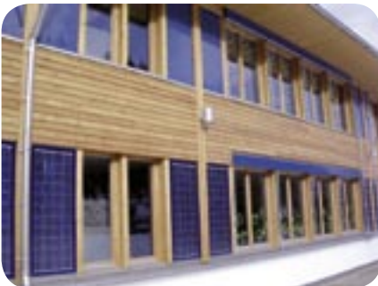
Abbildung 13: Öko-Volksschule Hermagor mit integrierten Photovoltaikerelementen. Auszeichnung: Energy Award 2005. Planung: Architekten Herwig und Andrea Ronacher (Bildquelle: Arch. Ronacher)
