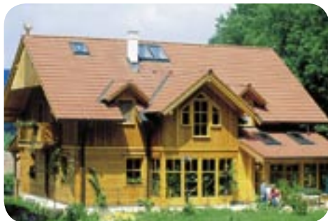
Abbildung 30: Holzwohnhaus in Breitenfurt (Bildquelle: ProHolz, A. Eder)
