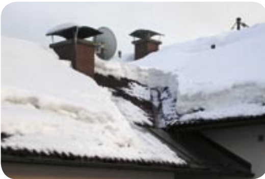
Abbildung 21: Vom Schnee befreite Dach- kehle (Bildquelle: Fritz Klaura)
