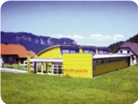
Abbildung 28: Behandelte Holzfassade, errichtet von Ing. E. Roth GmbH, WIGO-HAUS (Bildquelle: Fritz Klaura)
