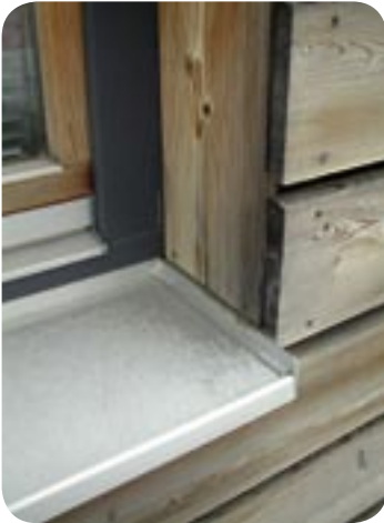
Abbildung 32: Fensterbank-, Sohlbankanschluss. Sicherung gegen Eindringen von Schlagregen und Flugschnee mittels Dichtmasse (Bildquelle: Fritz Klaura)
