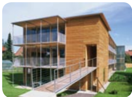
Abbildung 34: Wohnanlage Ölzbündt (Dornbirn, Vorarlberg); Architektur Büro DI Hermann Kaufmann ZT GmbH (Bildquelle: Ignacio Martinez)
