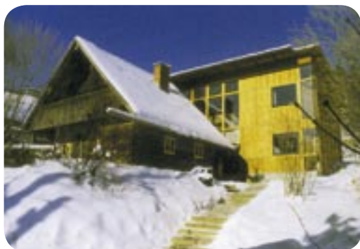
Abbildung 15: Altbauerweiterung Waidhofen (Quelle: proHolz, magk architektur)
