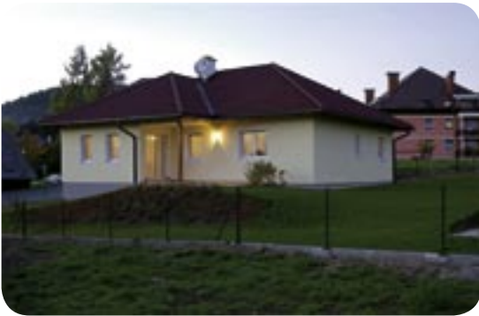
Abbildung 17: Bungalow mit Walmdach (Bildquelle: Ing. E. Roth GmbH, WIGO HAUS)
