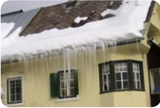
Abbildung 22: Vereiste Dachrinne in Kombination mit Eisrückstau (Bildquelle: Kurt Pock)
