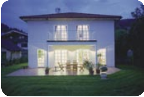
Abbildung 29: Holzrahmenbauweise mit Putzfassade (Bildquelle: Ing. E. Roth GmbH, WIGO HAUS)
