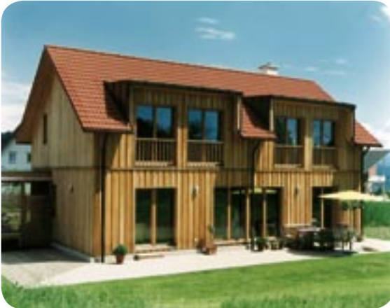
Abbildung 7: Holzbau mit großen Fensterflächen nach Süden (optimierte Tageslichtnutzung und Sonnenenergienutzung) (Bildquelle: Holzbau Themessl GmbH)
